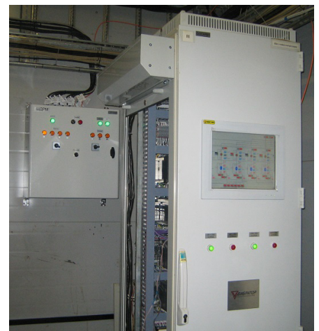
Рис. 6. Шкаф системы диагностики роторных машин (ШДРМ) и шкаф АСУ
